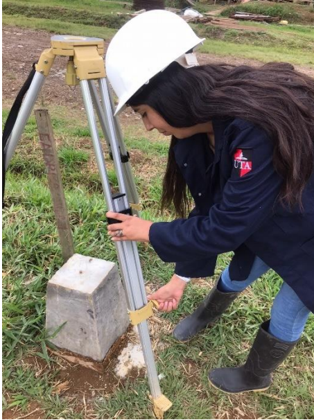
Colocación del trípode.
