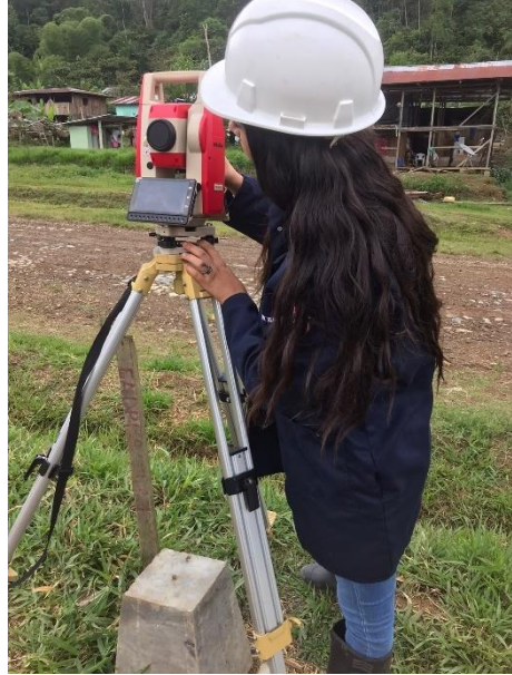
Nivelación y posicionamiento de la estación total.
