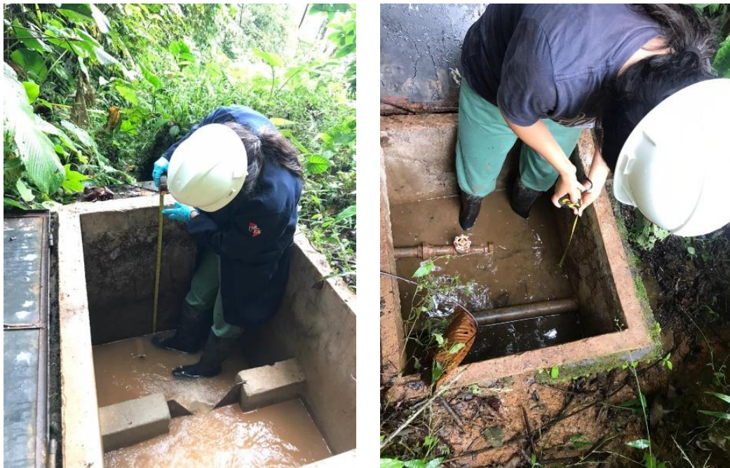
Ilustración 15. Medición de elementos hidráulicos de captación existentes.
