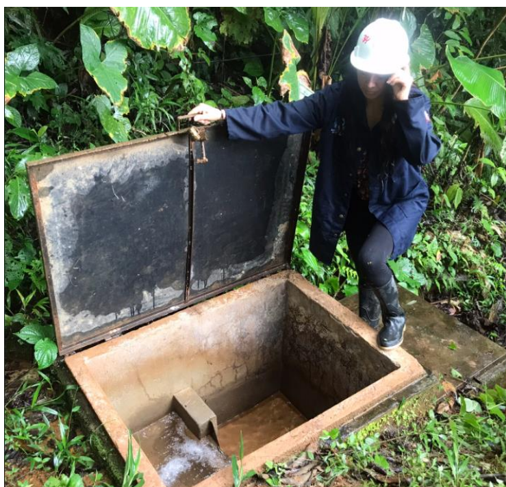
Ilustración 2. Inspección del sistema de agua actual.
