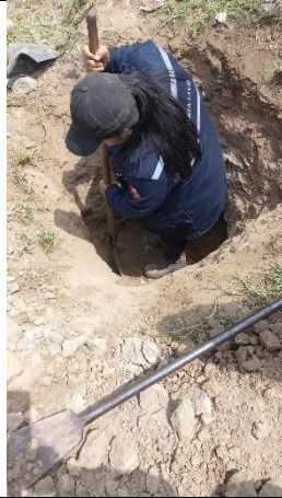
Excavación de calicatas para extracción de muestras.
