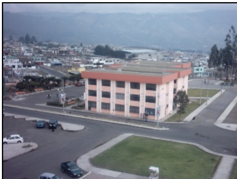
FOTOS LÍNEA DE VISTA CELDA HUACHI – 1.
