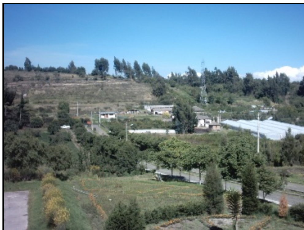
FOTOS LÍNEA DE VISTA CELDA QUEROCHACA – 1.
