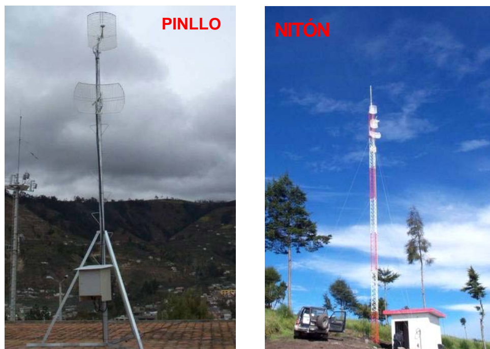
Figura 4.21. Infraestructura Técnica de la UTA.
