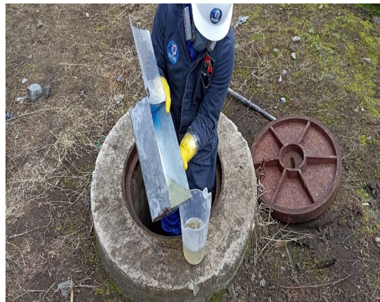
Figura 8.- Comprobación aforo del caudal de entrada a la PTAR de la comunidad Pilco, con un envase de volumen graduado
