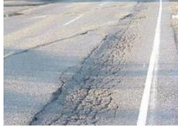
Figura 4 Ahuellamiento
