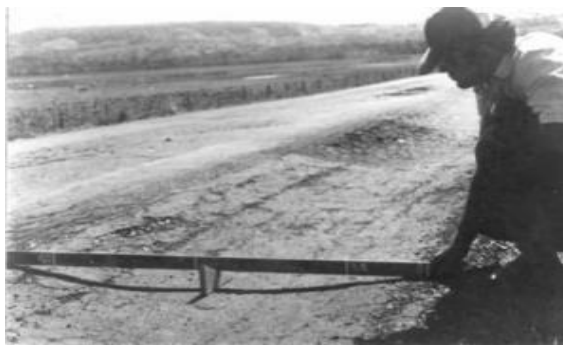
Figura 5.- Ahuellamiento
