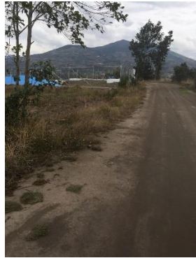
Estado actual de la Vía
