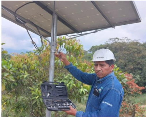
Figura 4-12: Verificación del ajuste del mástil y el panel solar.
