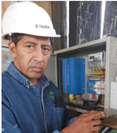
Figura 4-5: Comprobación del correcto estado de los conductores.
