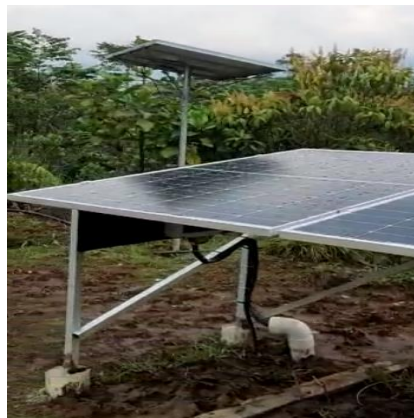
Figura 4-14: Verificación del estado soportes y anclajes del panel FV.
