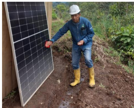
Figura 4-6: Limpieza del panel FV sin dañar la superficie del vidrio protector.
