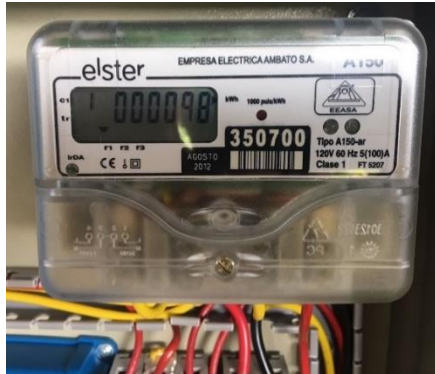
Figura 4-13: Verificación del estado y consumo del contador de energía.
