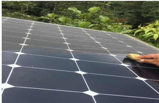
Figura 4-7: Mantenimiento preventivo (limpieza) del panel solar FV.
