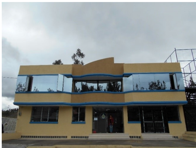
Figura 19. Edificio de la junta administradora de agua potable Picaihua Elaborado por: El investigador
