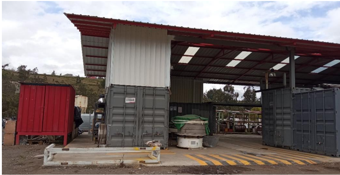
Figura 14. Taller de mantenimiento.
