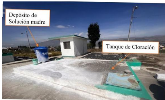
Figura 22 Sistema de cloración actual [57].
