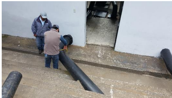
Figura 15 Bombeo desde captación hasta reservorio San Marcos [57].
