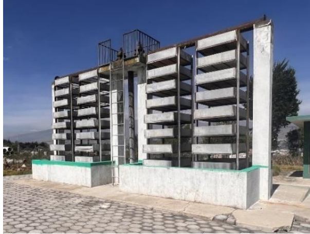
Figura 20 Bandejas de filtración y aireación [57].
