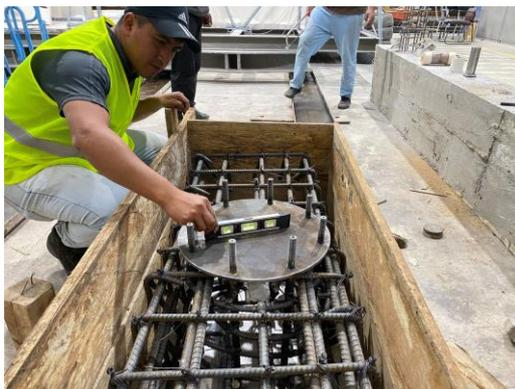
Figura 3- 8. Montaje de hierros de la cimentación de hormigón armado [Autor]
