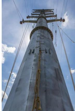
Figura 2- 6. Monopolo de sección poligonal unido mediante bridas apernadas [29].
