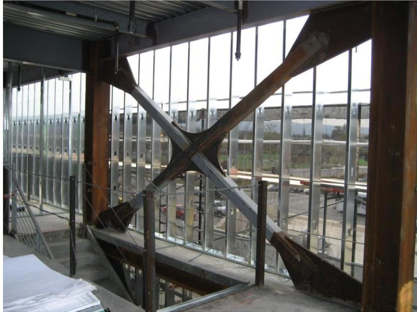
Figura 2- 6: Pórtico arriostrado concéntricamente [12]
