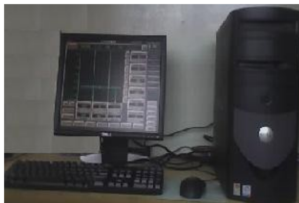
Figura 4.15. Estación de trabajo (Cliente)
