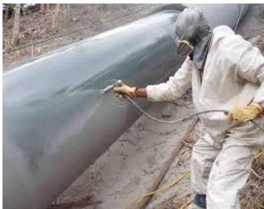
Figura 5. Limpieza con solventes [15]
