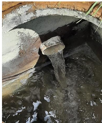
Figura 37 Tubería pozo de salida
