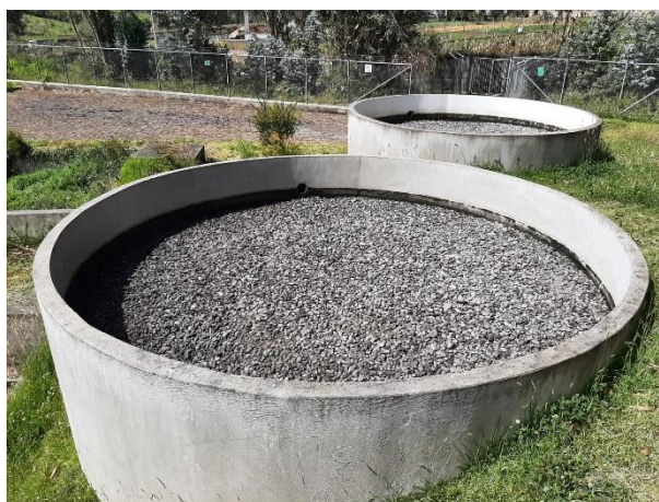
Figura 29 Material filtrante en el interior de cada filtro
