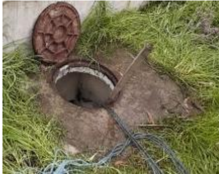
Figura 36 Pozo de salida
