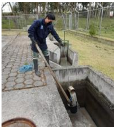
Figura 2 Medición de caudales de entrada de la PTAR
