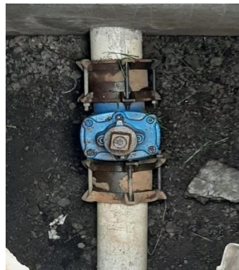
Figura 24 Válvula de paso hidráulica
