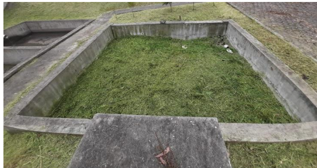
Figura 33 Lecho filtrante descendente
