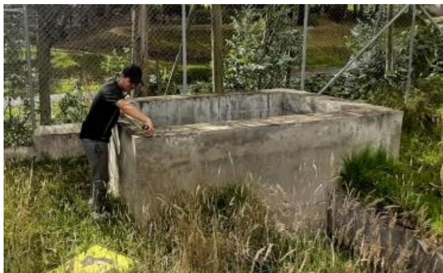
Figura 55 Medición del pozo recolector
