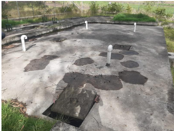
Figura 20 Tanque séptico de sedimentación primaria
