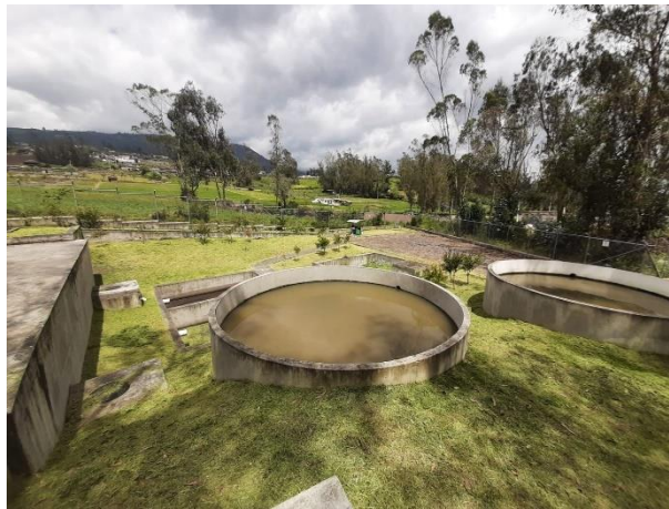
Figura 28 Filtro anaerobio de flujo ascendente 1 y 2 (FAFA)
