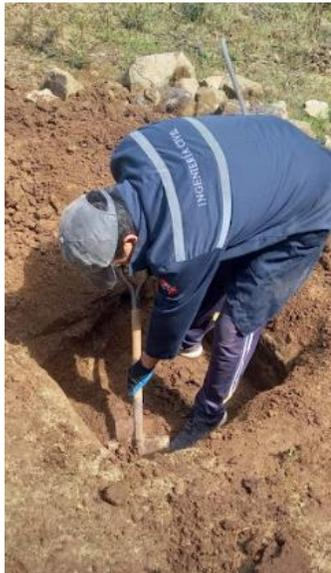
**Figura 59.** Excavación de calicatas
