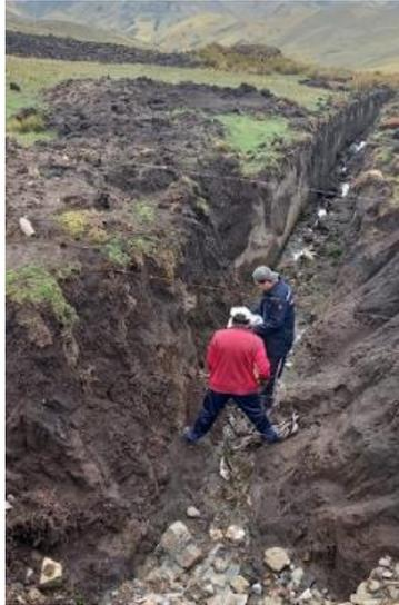
**Figura 58.** Visita en campo para excavar las calicatas
