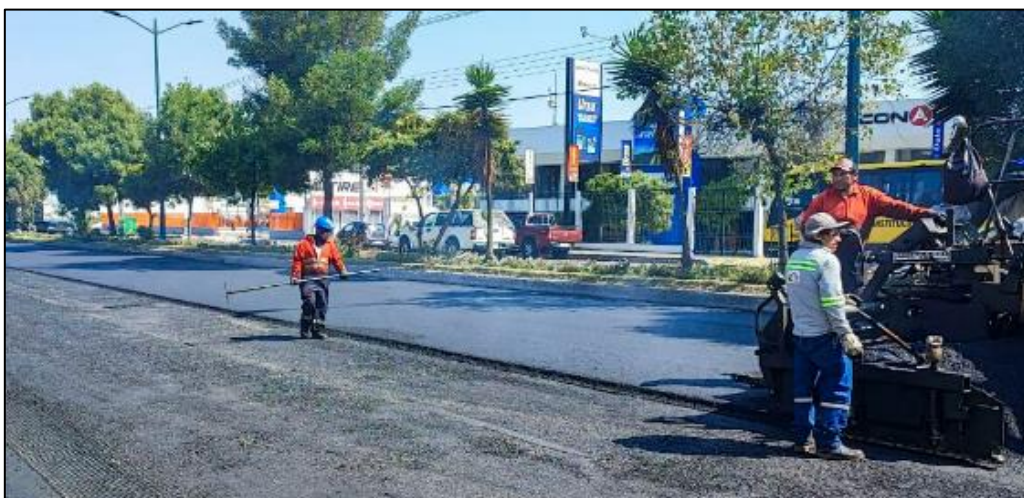
Fig. 11 Capa de rodadura Av. Bolivariana
