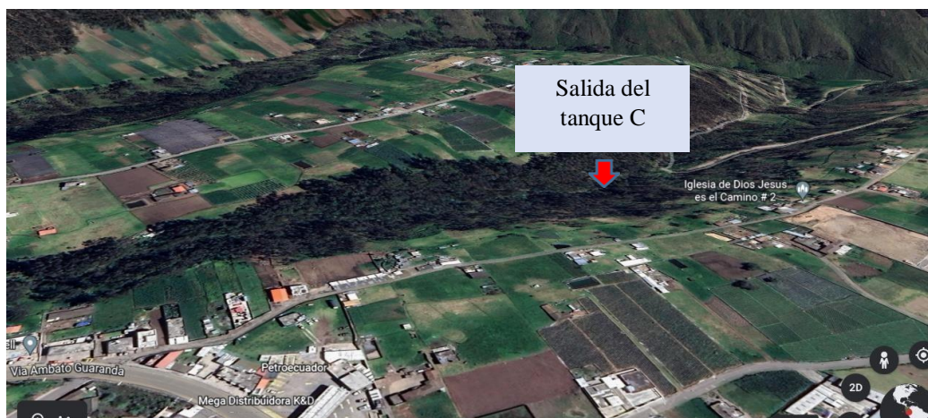
Fotografía 3 Ubicación GPS de la salida del tanque C de la red de distribución de agua Toallo el Quinche. Noviembre 2022.
