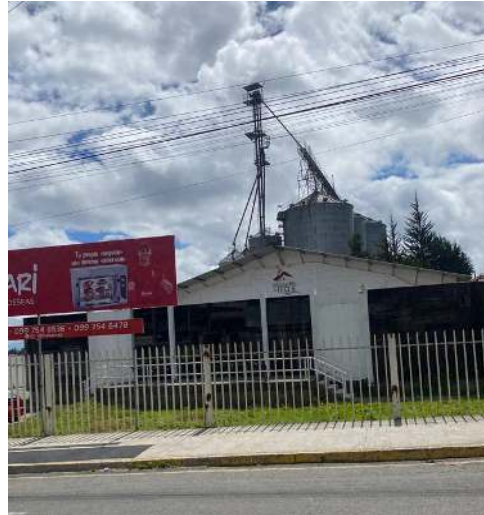
Fotografía de la fachada
