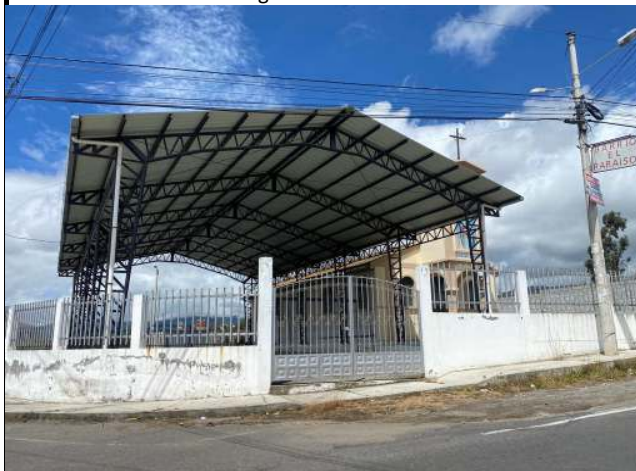
Fotografía de la fachada
