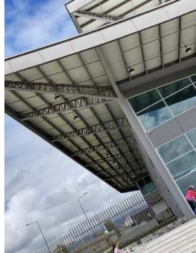
Fotografía de la fachada
