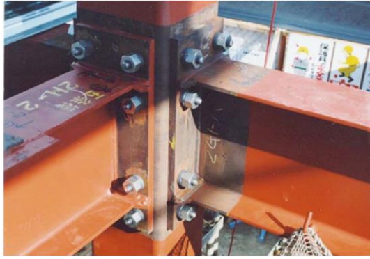
Figura 2-1: Conexión rígida para columnas rellenas de hormigón [25]
