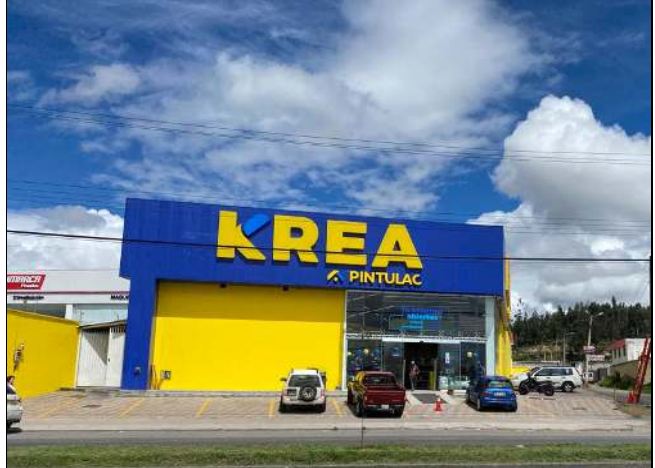
Fotografía de la fachada
