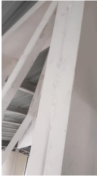
Figura 4- 15: Cordones de soldadura discontinuos
