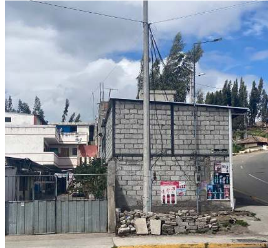
Fotografía de la fachada
