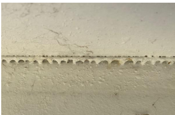
Figura 4- 64: Falta de fusión del cordón de soldadura
