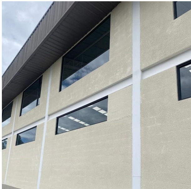
Figura 4- 10: Columnas y vigas de soporte del sistema estructural de la edificación 19
