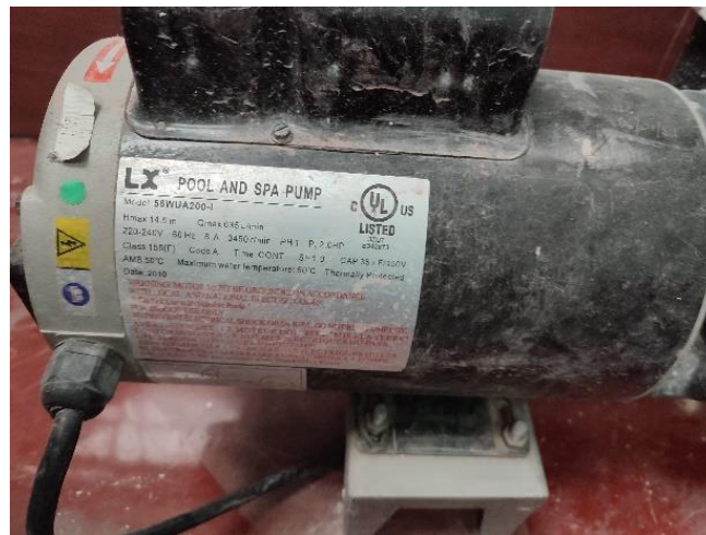
Figura - 21- Placa técnica de la Bomba de Agua
