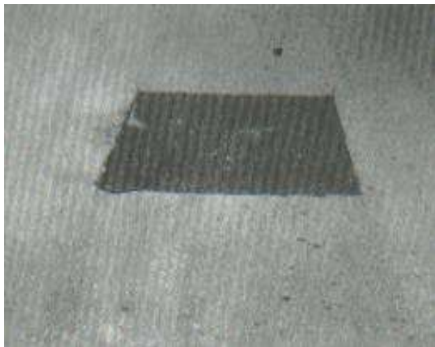
Gráfica 47 Parcheo con nivel de severidad bajo
