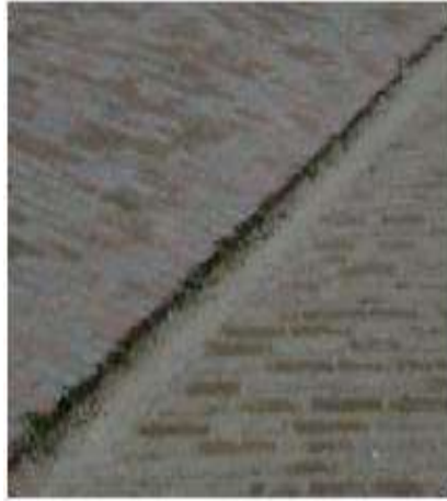
Gráfica 101 Escalonamiento entre adoquines
