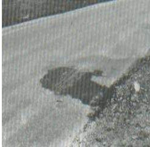
Gráfica 48 Parcheo con nivel de severidad medio
