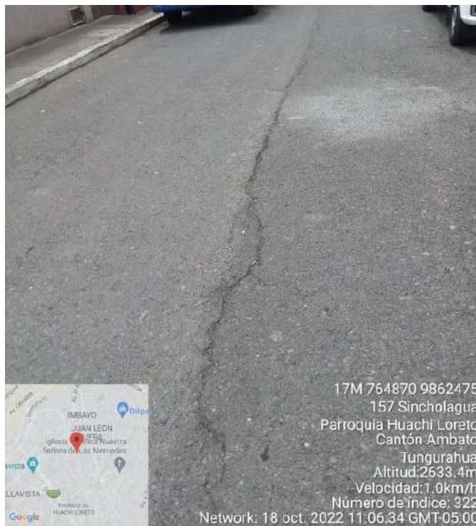
Gráfica 159 Daño representativo tipo Grieta Longitudinal y Transversal Fuente: Daniela Leyton (2023)
