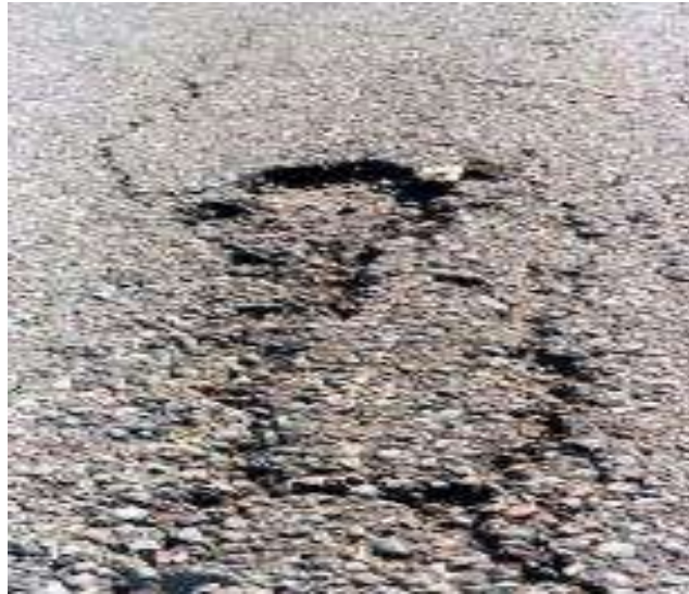
Gráfica 51 Huecos Fuente: Manual de Pavimentos-2004
