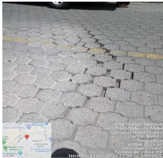
Gráfica 192 Daño representativo tipo Juntas Abiertas Fuente: Daniela Leyton (2023)
