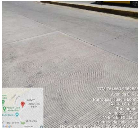
Gráfica 171 Daño representativo tipo Desgaste Superficial Fuente: Daniela Leyton (2023)
