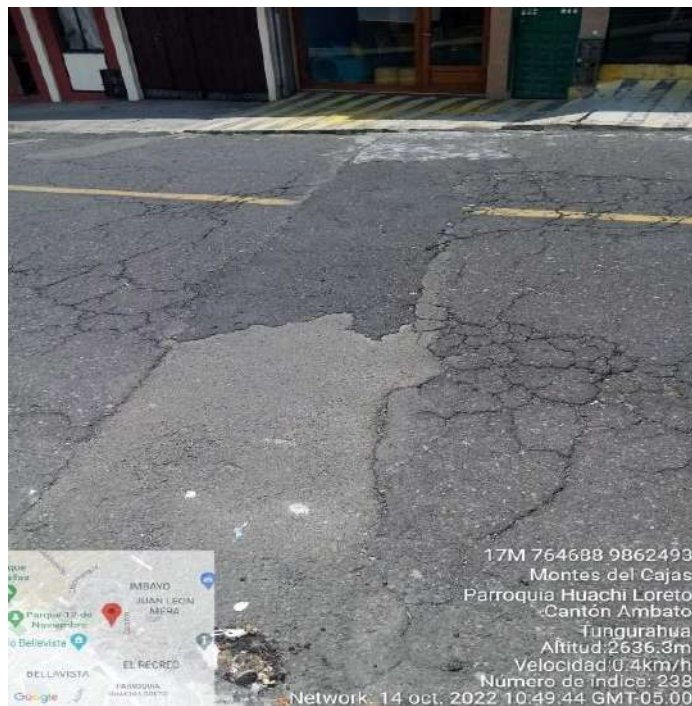
Gráfica 162 Daño representativo Tipo Parcheo Fuente: Daniela Leyton (2023)
