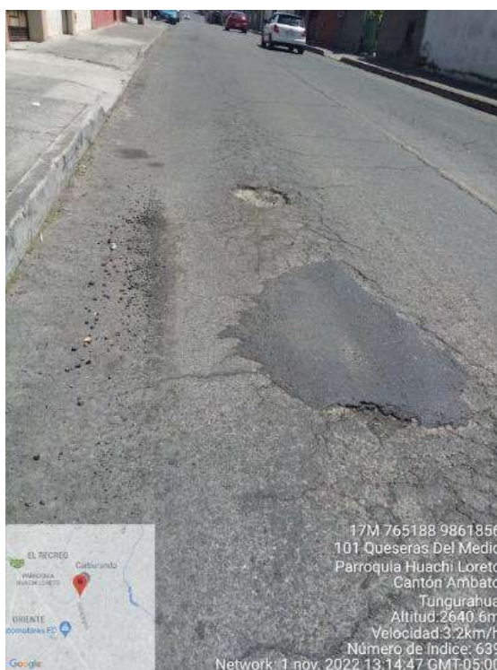
Gráfica 147 Daño representativo tipo Piel de Cocodrilo Fuente: Daniela Leyton (2023)
