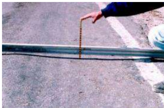
Gráfica 58 Ahuellamiento Fuente: Manual de Pavimentos-2004
