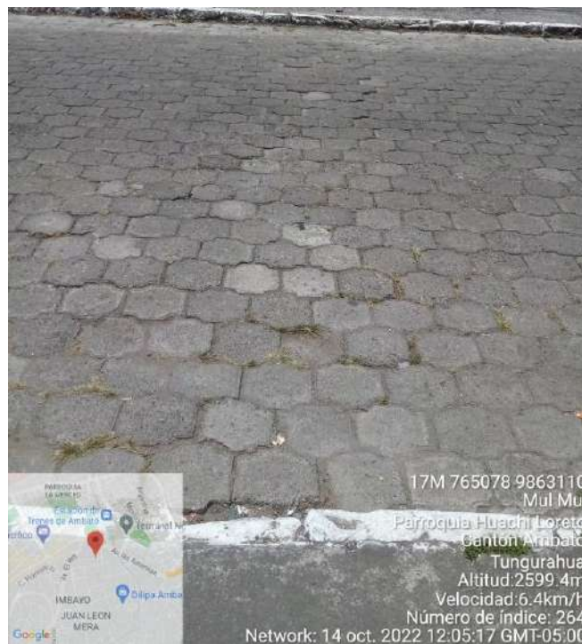
Gráfica 180 Daño representativo tipo abultamiento Fuente: Daniela Leyton (2023)
