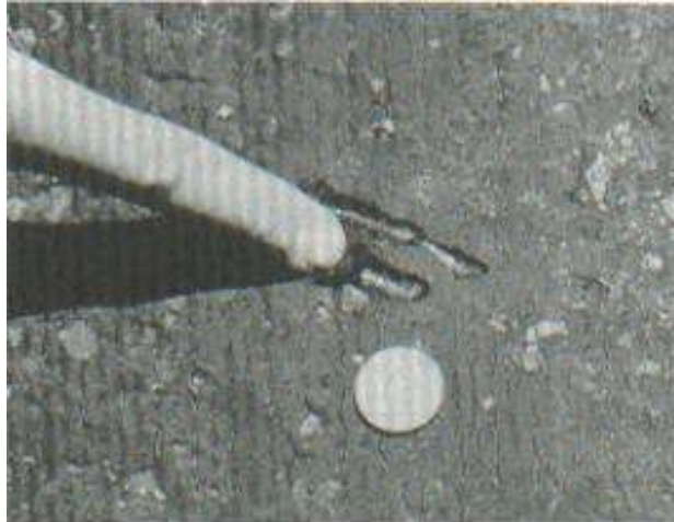
Gráfica 12 Exudación nivel de deterioro medio
