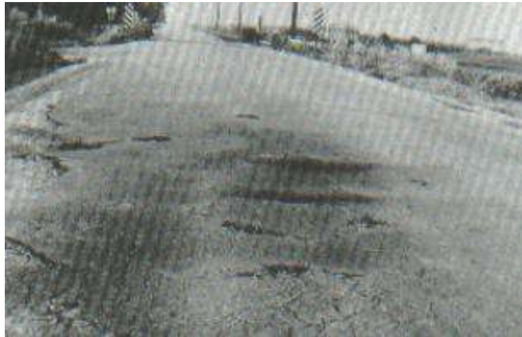
Gráfica 64 Desplazamiento con un nivel de deterioro medio Fuente: L. Vásquez, Pavement Condition Index (PCI) para pavimentos asfálticos y de concreto en carreteras-2002
