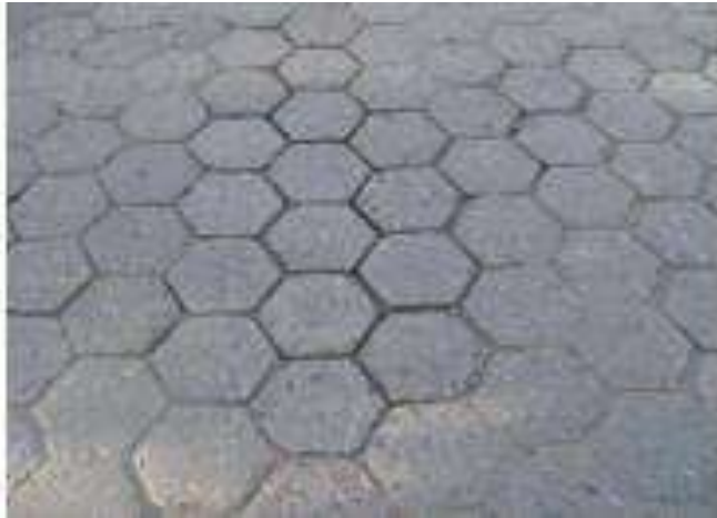
Gráfica 102 Escalonamiento entre adoquines
