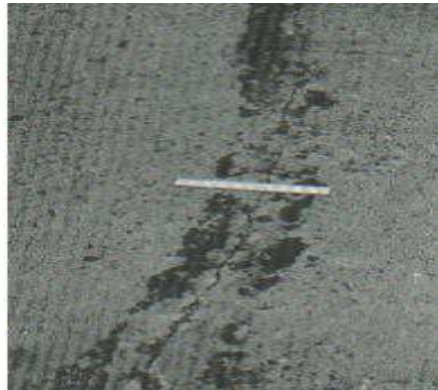
Gráfica 76 Grietas con un nivel de deterioro bajo de una losa de concreto simple Fuente: L. Vásquez, Pavement Condition Index (PCI) para pavimentos asfálticos y de concreto en carreteras-2002
