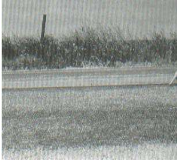
Gráfica 23 Corrugaciones nivel de deterioro bajo
