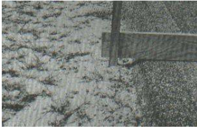
Gráfica 39 Desnivel carril/ berma nivel de deterioro bajo Fuente: L. Vásquez, Pavement Condition Index (PCI) para pavimentos asfálticos y de concreto en carreteras-2002
