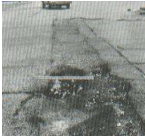
Gráfica 49 Parcheo con nivel de severidad alto
