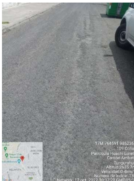
Gráfica 156 Daño representativo tipo Corrugación Fuente: Daniela Leyton (2023)
