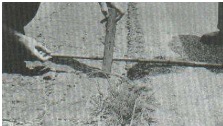
Gráfica 40 Desnivel carril/ berma nivel de deterioro medio Fuente: L. Vásquez, Pavement Condition Index (PCI) para pavimentos asfálticos y de concreto en carreteras-2002
