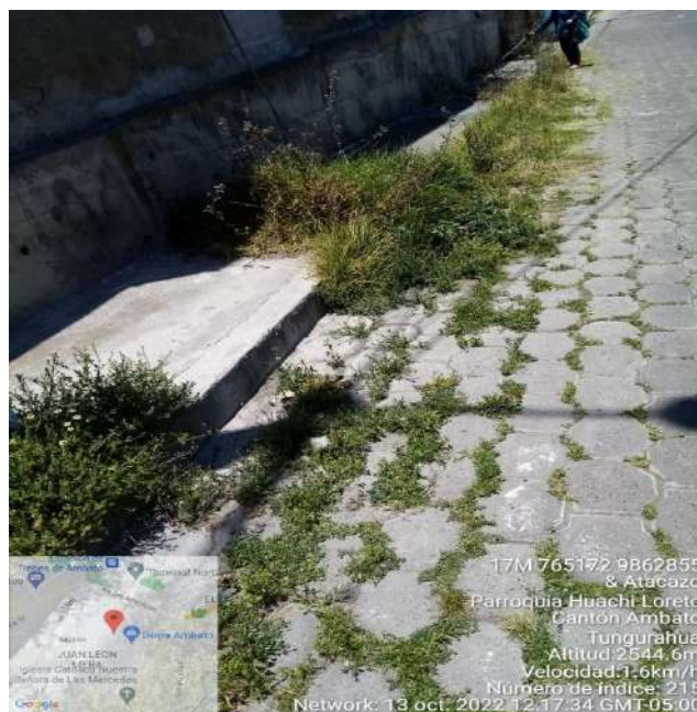
Gráfica 195 Daño representativo tipo Vegetación en la Calzada Fuente: Daniela Leyton (2023)
