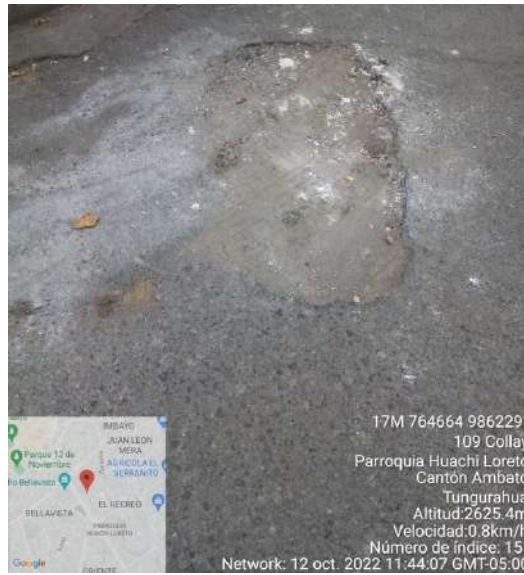
Gráfica 168 Daño representativo tipo Huecos Fuente: Daniela Leyton (2023)
