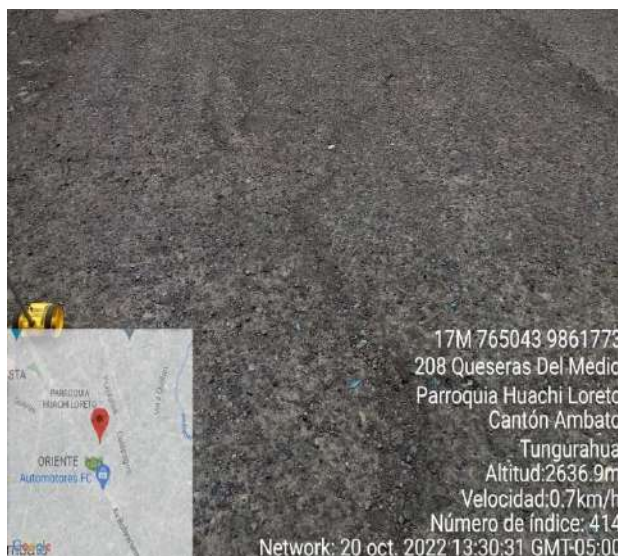
Gráfica 165 Daño representativo tipo Pulimiento de Agregados Fuente: Daniela Leyton (2023)
