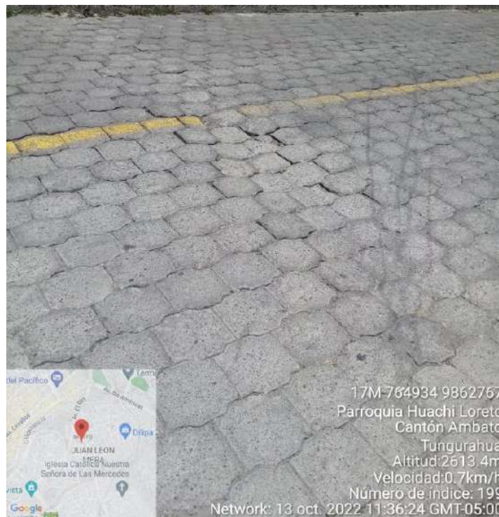
Gráfica 186 Daño representativo tipo Depresiones Fuente: Daniela Leyton (2023)
