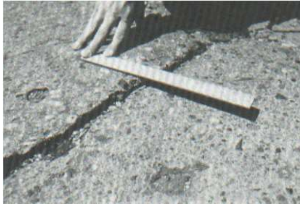
Gráfica 29. Escalonamiento de junta.
