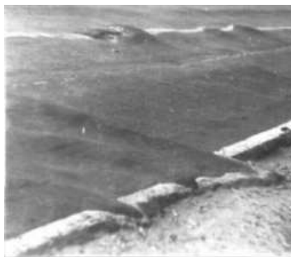
Gráfica 5. Corrimiento de severidad alta.
