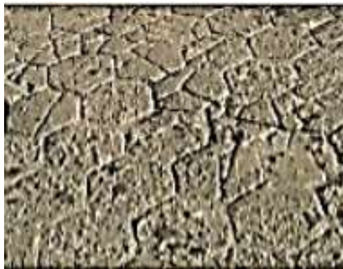
Gráfica 41. Fracturamiento en pavimento articulado.
