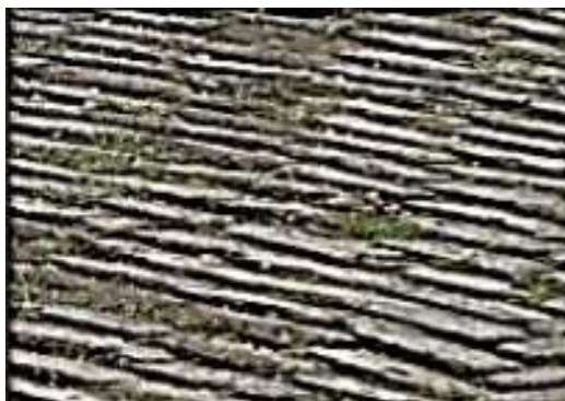
Gráfica 44. Escalonamiento de adoquines en pavimento articulado.
