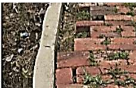
Gráfica 39. Desplazamiento de borde en pavimento articulado.
