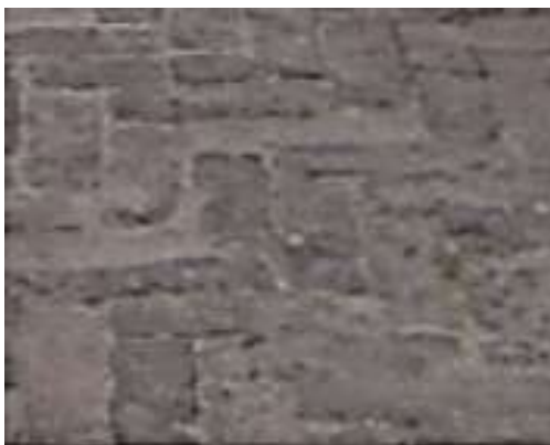
Gráfica 38. Perdidas de arena en pavimento articulado.
