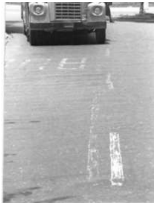
Gráfica 4. Corrugación severidad alta.
