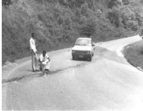
Gráfica 3. Hundimiento de severidad alta.
