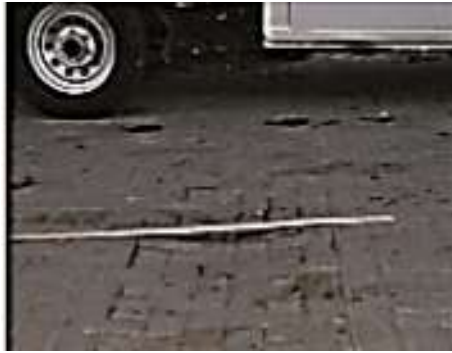
Gráfica 36. Depresión en pavimento articulado.
