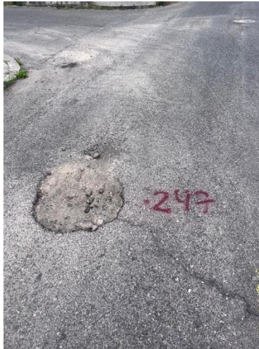
Gráfico 9: Huecos – Pavimento Flexible
