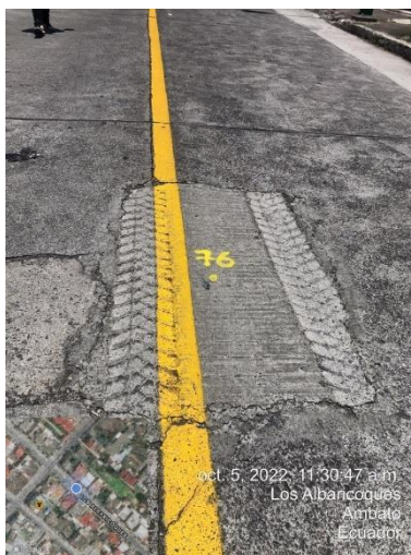
Gráfico 12: Desgaste superficial – Pavimento Rígido
