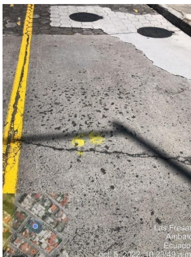
Gráfico 14: Agrietamiento en bloque – Pavimento Rígido
