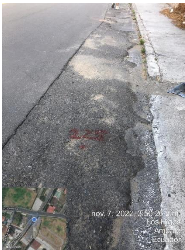
Gráfico 8: Pulimento de agregados – Pavimento Flexible
