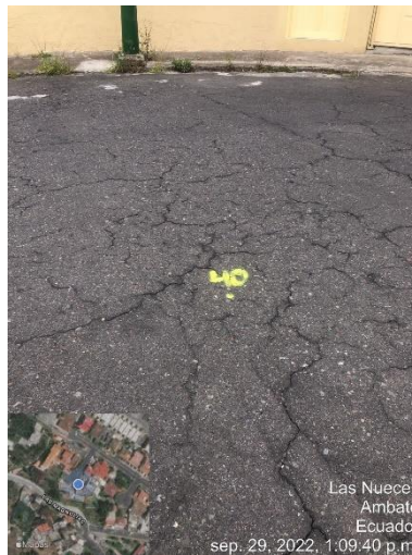
Gráfico 2: Piel de Cocodrilo – Pavimento Flexible
