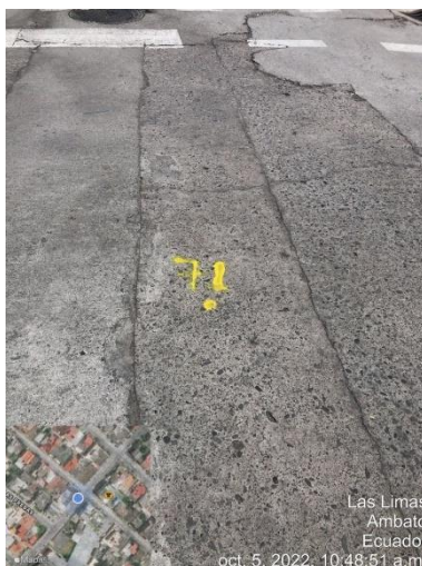
Gráfico 17: Fallas selladas – Pavimento Rígido
