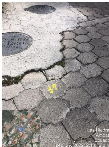
Gráfico 22: Desgaste superficial – Pavimento Articulado
