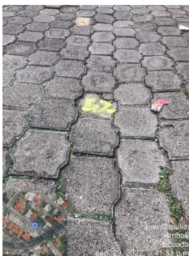
Gráfico 21: Depresiones – Pavimento Articulado
