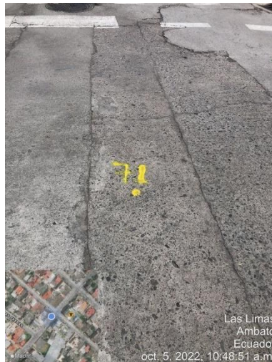
Gráfico 18: Levantamiento de Juntas – Pavimento Rígido
