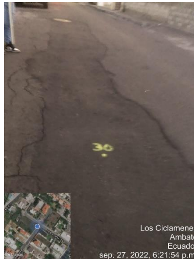
Gráfico 7: Parcheo – Pavimento Flexible
