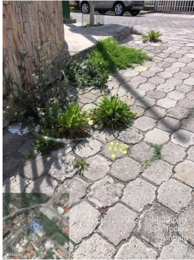
Gráfico 26: Vegetación en la calzada – Pavimento Articulado
