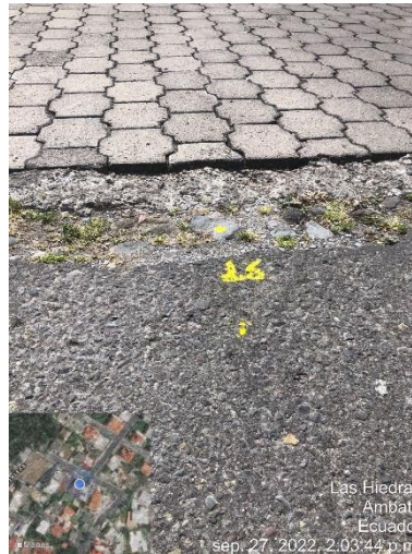
Gráfico 5: Desnivel de carril/Berma – Pavimento Flexible
