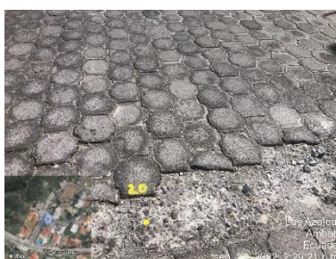
Gráfico 25: Junta Abierta – Pavimento Articulado
