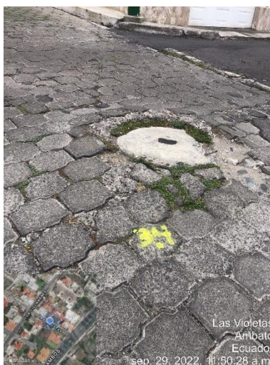
Gráfico 19: Abultamiento – Pavimento Articulado
