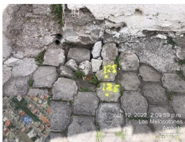
Gráfico 24: Fracturamiento – Pavimento Articulado
