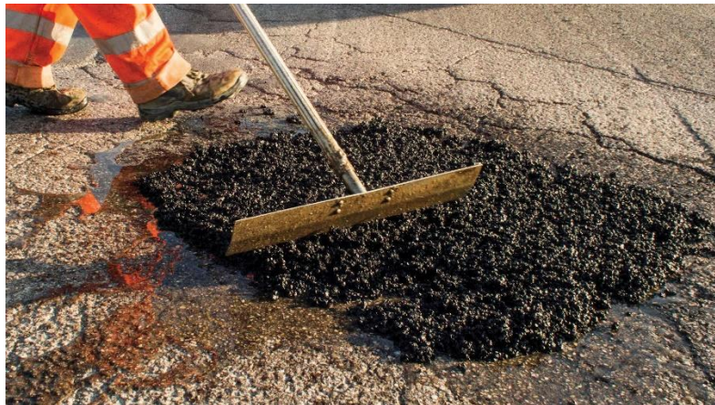
Figura 1. Bacheo con mezcla asfáltica en frío
