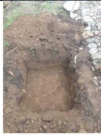
Anexo F-54 Calicata de 1mx1m y 1m de profundidad después de retirar la capa vegetal.
