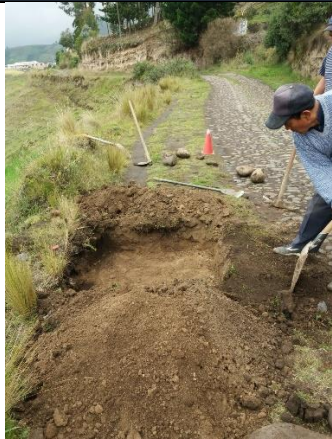
Anexo F-53 Excavación de calicatas.
