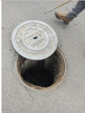
Figura 43. Levantamiento topográfico para la red nueva del proyecto.
