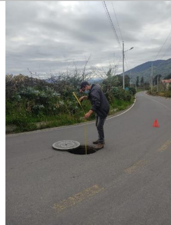
Figura 46. Toma de dimensiones de los pozos de la red de descarga.
