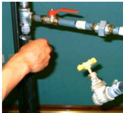
Figura 5.3 Parte inferior de la tubería
