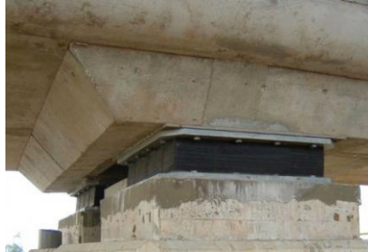
Figura 1 Aislador de cuacho natural con nucelo de plomo, LASTO-LRB
