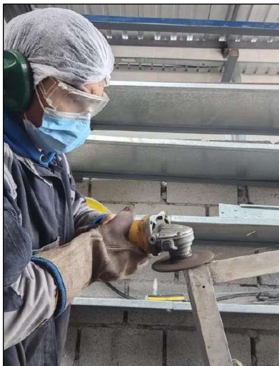
Fotografía 5.15: construcción estructura tablero eléctrico.
