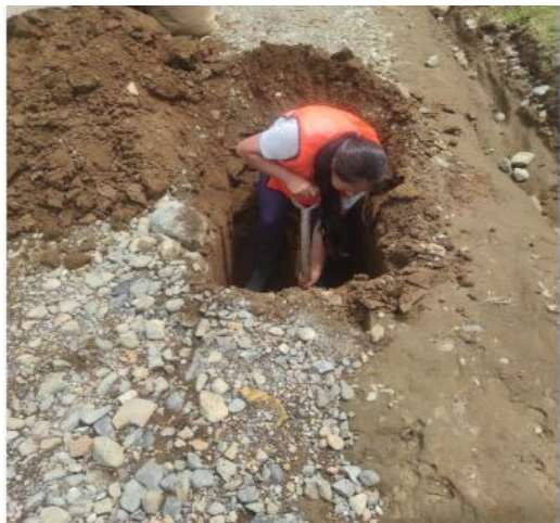
G1.7 Cavando la calicata.
