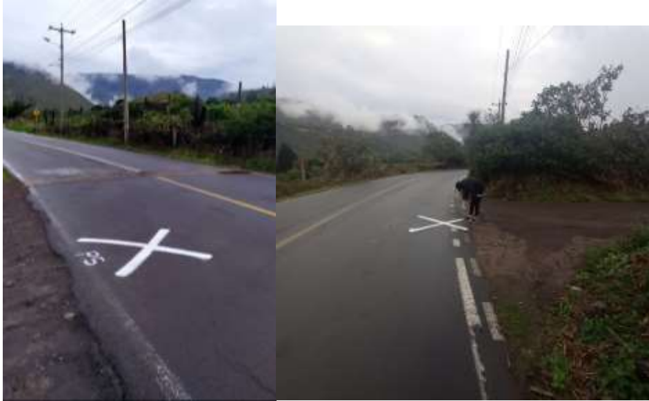
Fotografía N°1 Señalización de puntos de control
