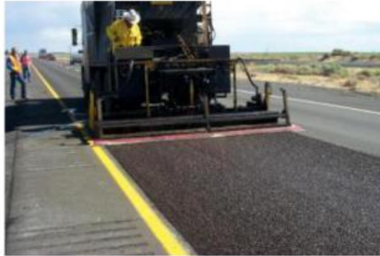
Figura 28. Colocación de capa asfáltica flexible
