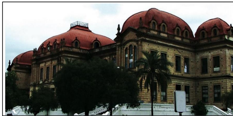
Figura 14. Edificio del Colegio Benigno Malo
