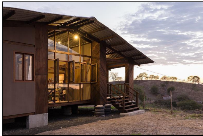
Figura 21. Vivienda sismoresistente construida con madera
