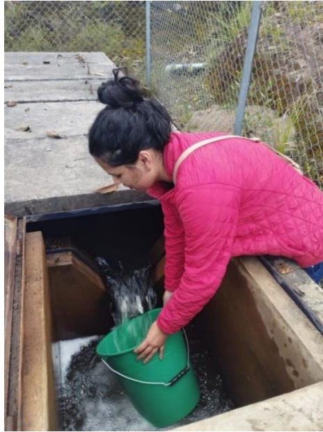
Imagen 13. Toma de caudales de entrada
