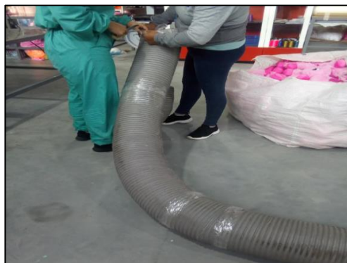
Figura 30: Reparación tubo de almacenamiento área de relleno
