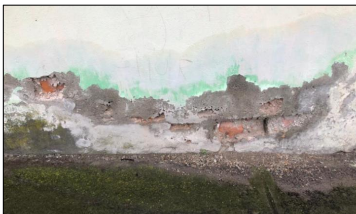
Figura 59. Erosión química.
