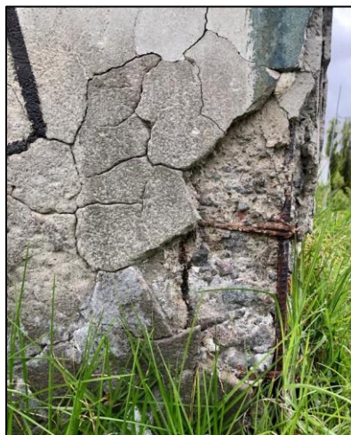
Figura 65. Ataque por sulfatos.
