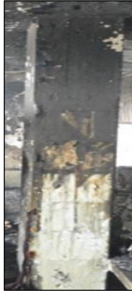
Figura 77. Ataque por altas temperaturas.
