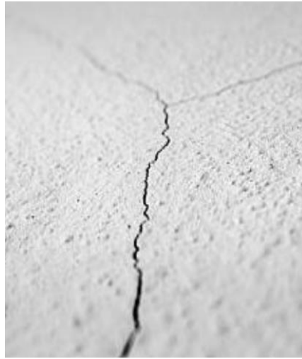
Figura 10. Fisuras.
