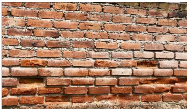
Figura 26. Erosión Física.
