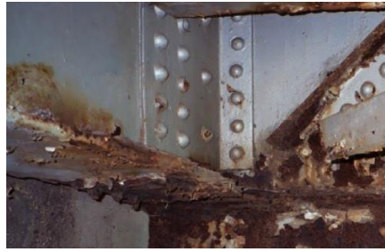
Figura 14. Corrosión.
