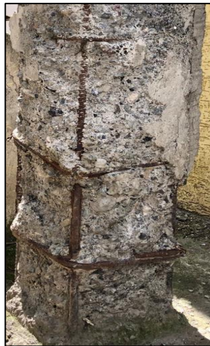
Figura 69. Carbonatación.
