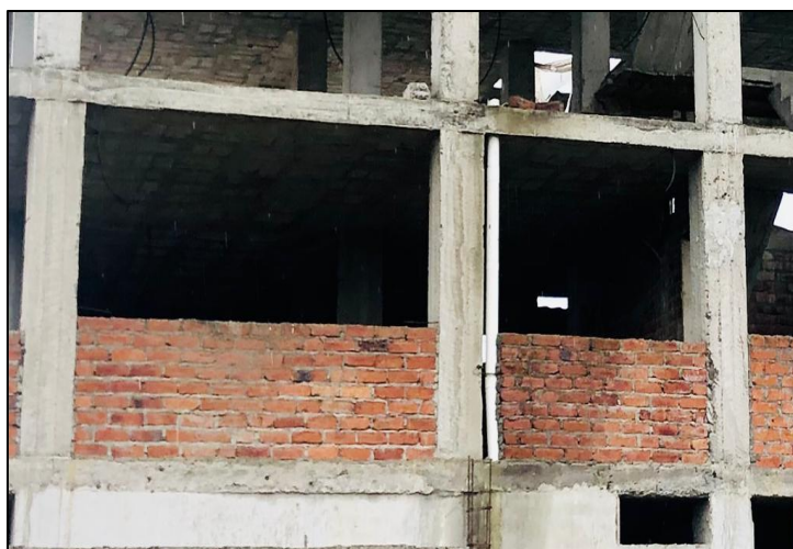
Figura 79. Columna Corta.
