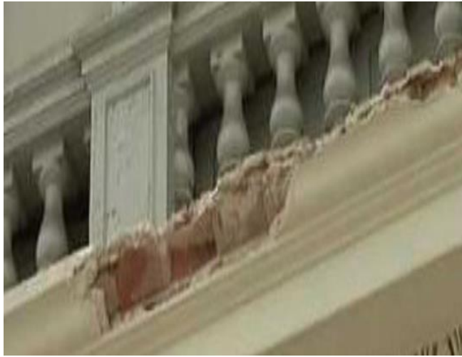
Figura 12. Erosiones Mecánicas.
