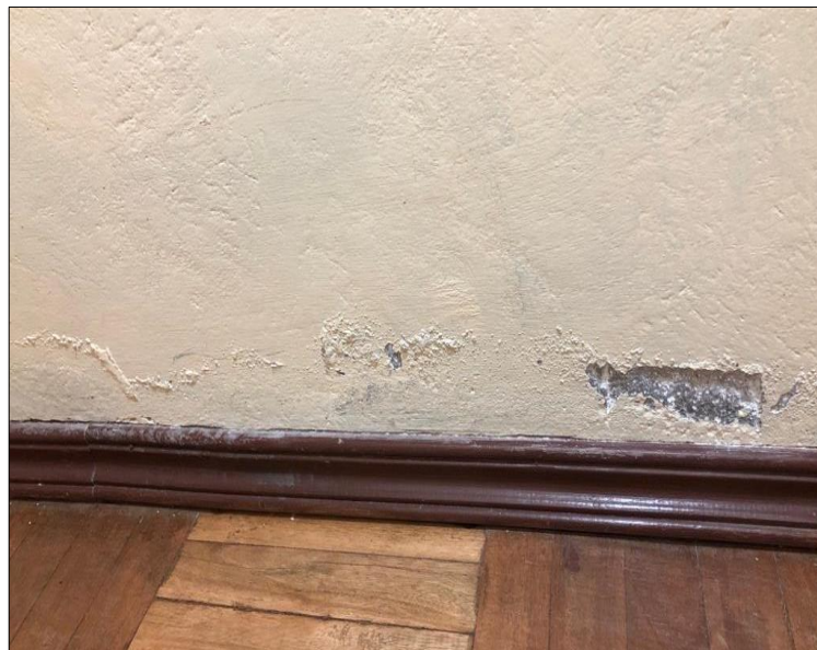
Figura 17. Humedad Capilar.
