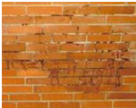
Figura 16. Erosiones Químicas.
