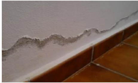
Figura 2. Humedad capilar.
