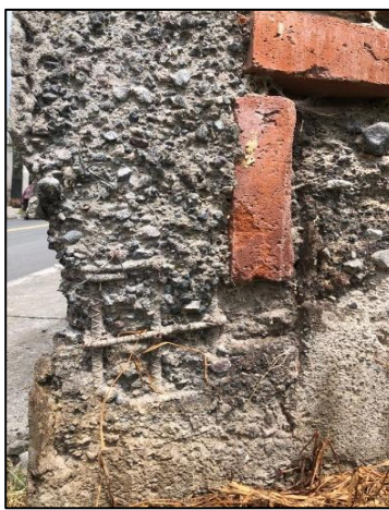
Figura 63. Ataque por ácidos.
