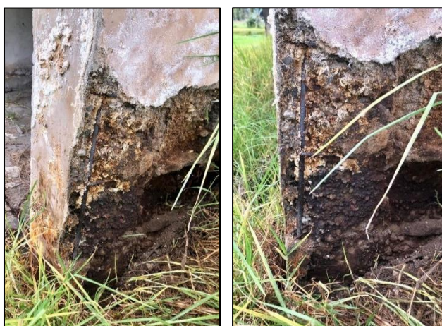
Figura 67. Ataque por cloruros.
