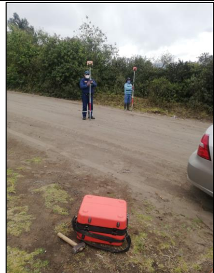
Toma de puntos con el prisma
