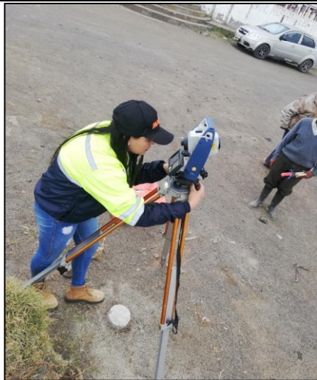
Nivelación de la Estación Total
