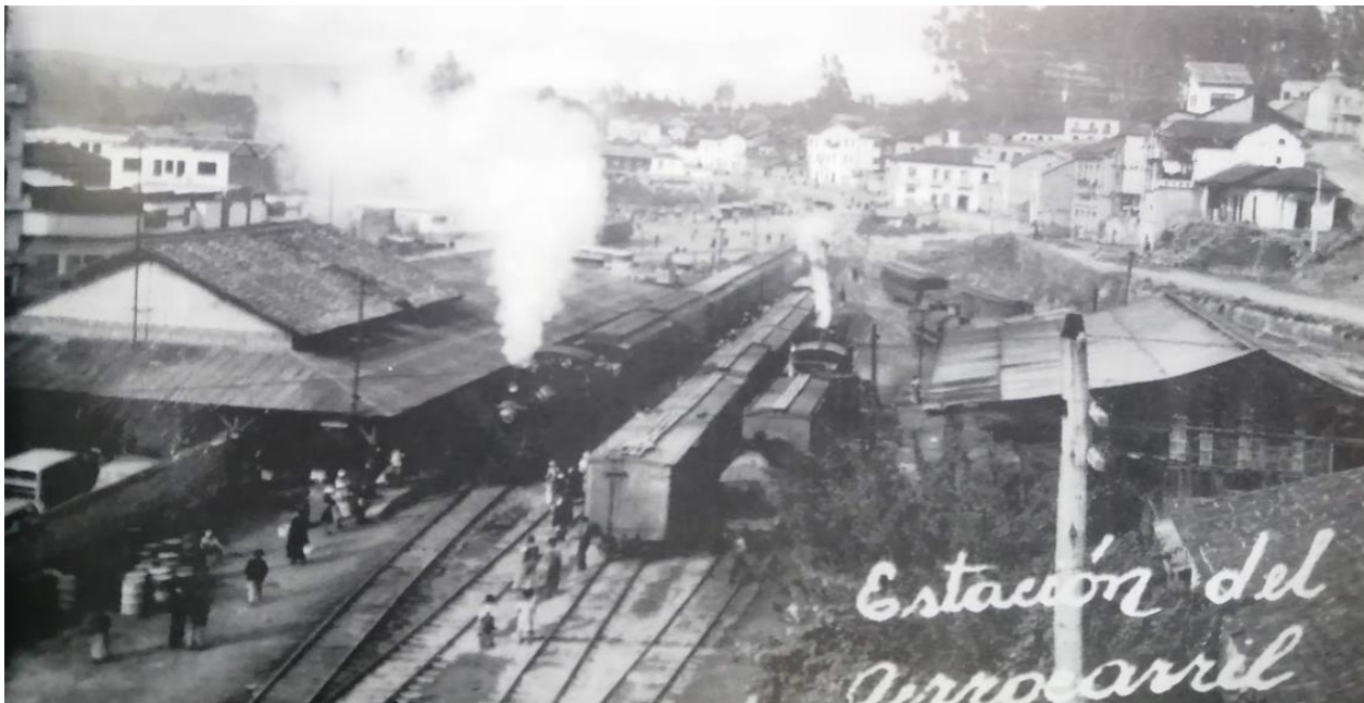
Figura 27 Línea Férrea Ambato
