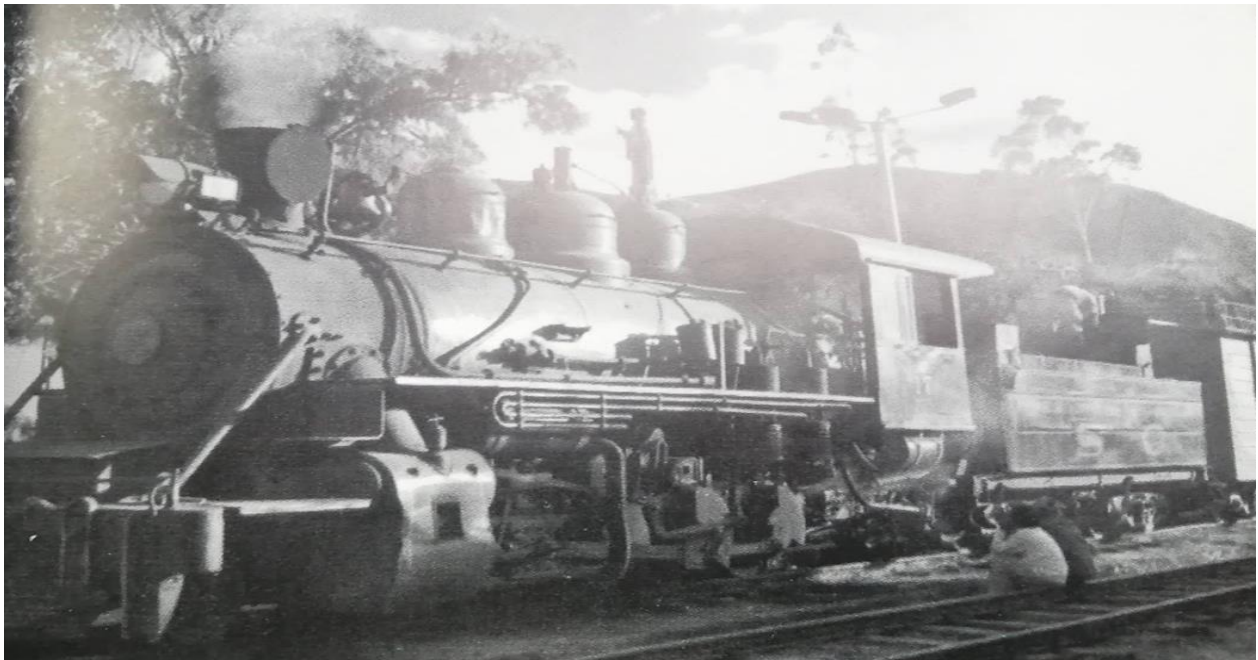
Figura 30 Línea Férrea Ambato
