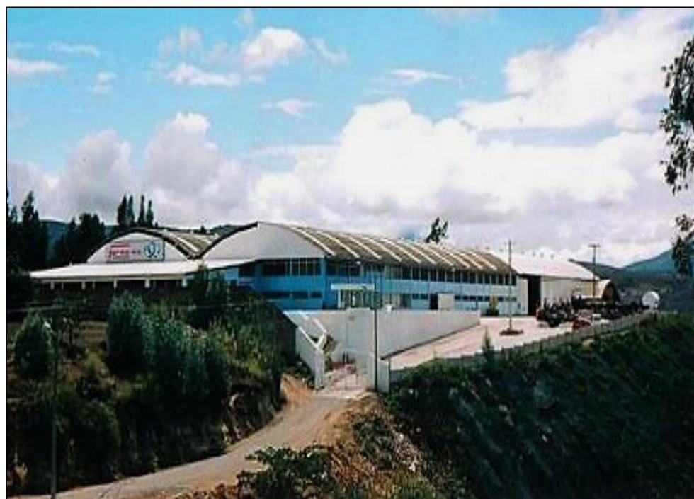
Figura 8: Fachada de la empresa.
