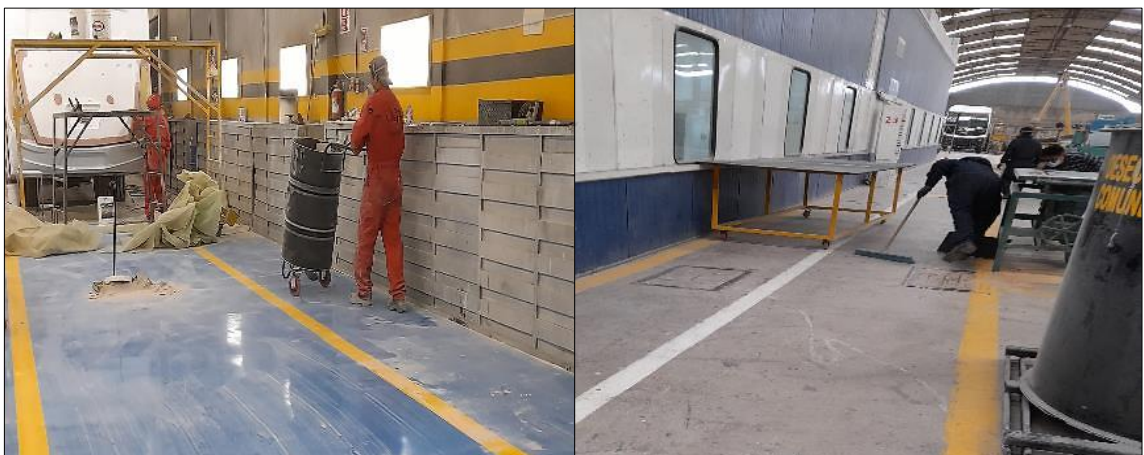
Figura 23: Limpieza de la sección de pintura.
