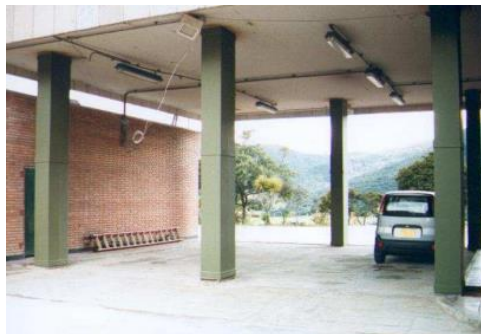
Figura 22: Encamisado metálico
