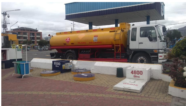
Gráfico 11. Área de Descarga de Combustibles
