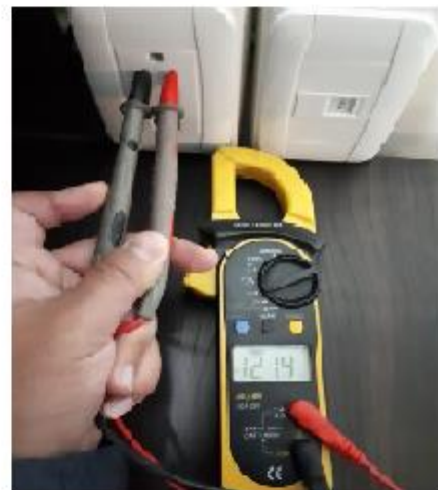
Voltaje en la Red Eléctrica
