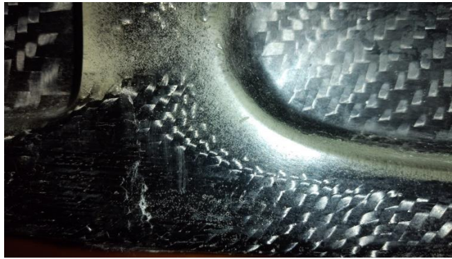
Figura 22. Iluminación con lámpara de las zonas a inspeccionar.
