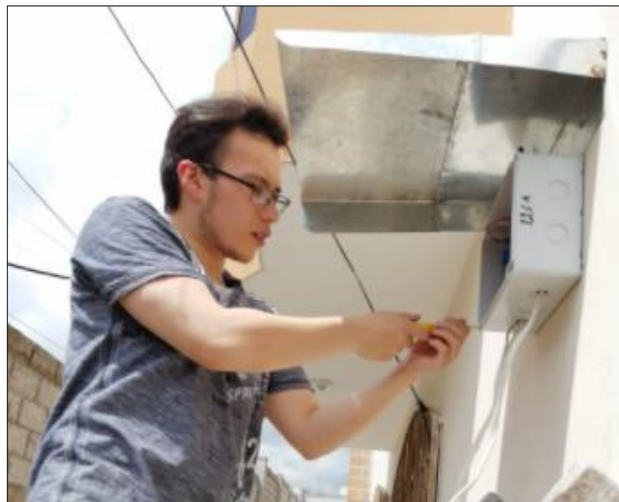
Figura 71: Instalación de los nodos finales en las viviendas
