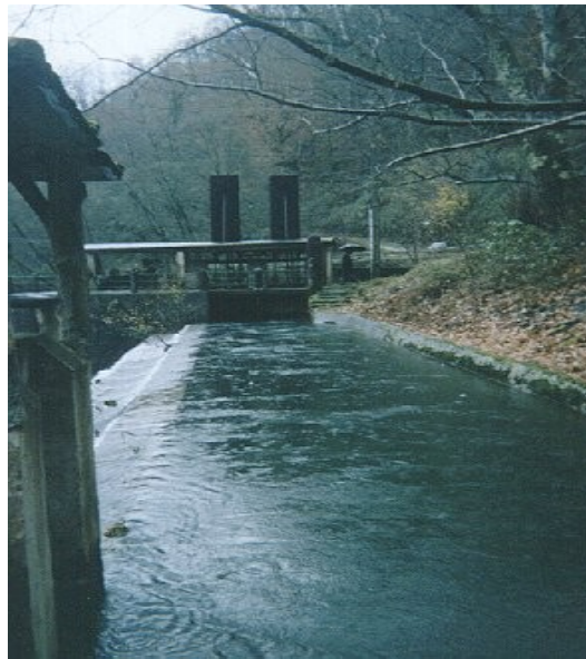
Figura 4. Toma de agua para pequeñas centrales
