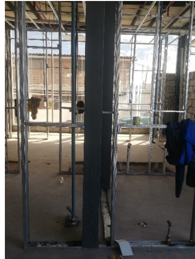
Foto 4: Estructura de baños y duchas
