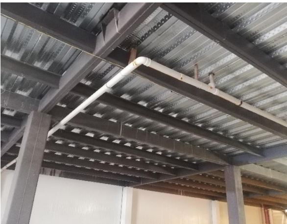
Foto 7: Instalación de agua
