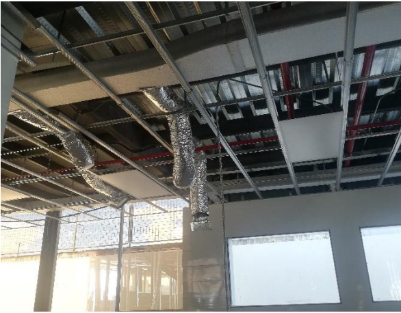
Foto 5: Instalación de aire
