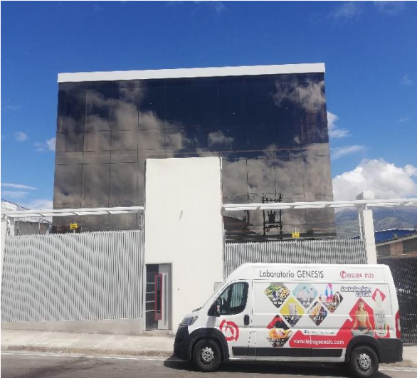
Foto 1: Fachada de planta nueva
