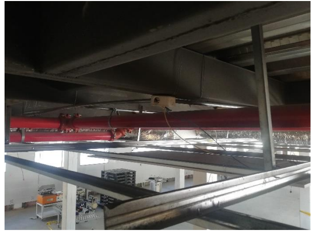
Foto 6: Instalación de presión
