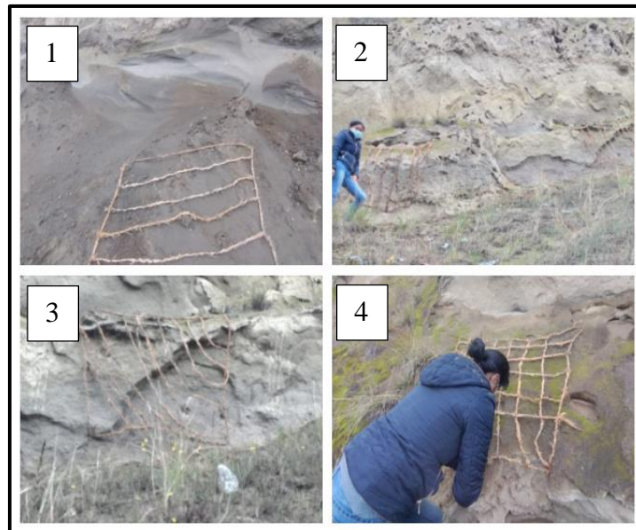
FIGURA 60. Implantación de las mallas en el Talud
