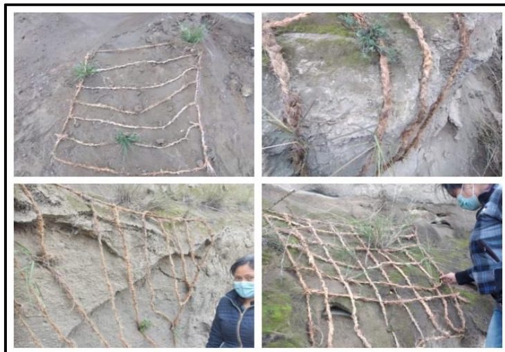
FIGURA 61. Resultados de las mallas en el Talud
