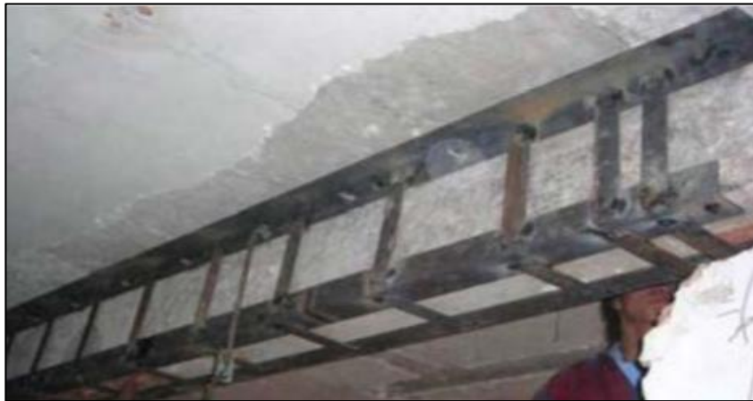
Figura 106: Encamisado de viga
