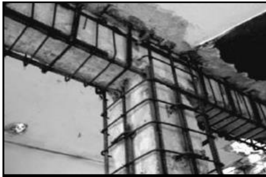
Figura 26: Encamisado de concreto reforzado
