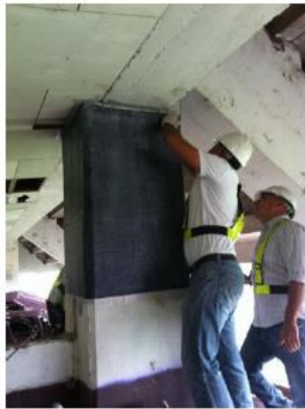
Figura 19: Reforzamiento con FRP
