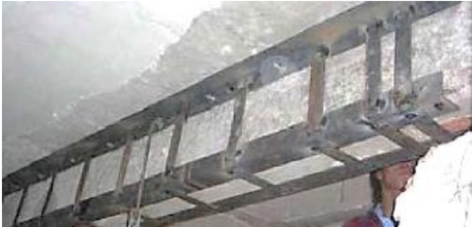
Figura 119: Reforzamiento de viga con encamisado metálico
