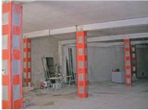
Figura 17: Encamisado metálico en columna
