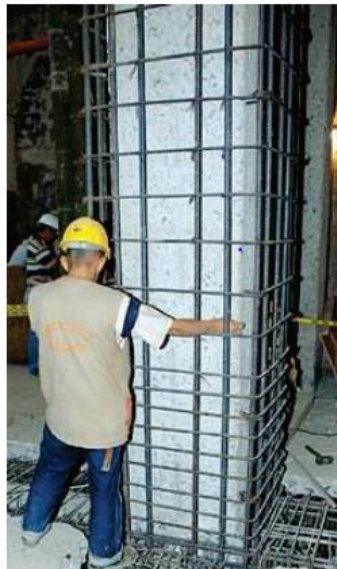
Figura 16: Incremento de sección y cuantías de acero
