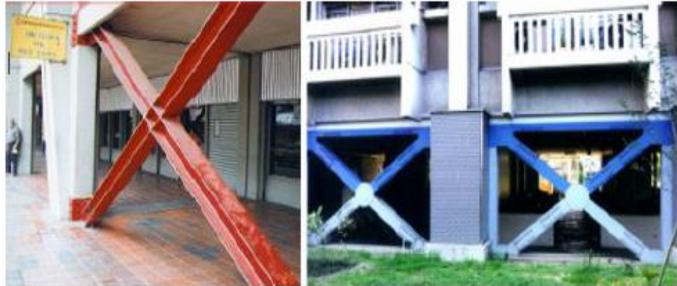
Figura 21: Diagonales rigidizadoras en pórticos de H.A.
