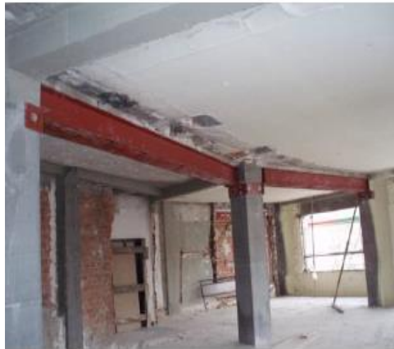
Figura 18: Encamisado metálico en viga
